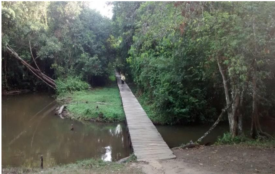
Figura 4: Ponte sobre o Rio Igarapé-Açu
