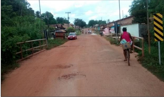
Figura 6: Ponte sobre o Rio Igarapé-Açu no Bairro São Cristovão
