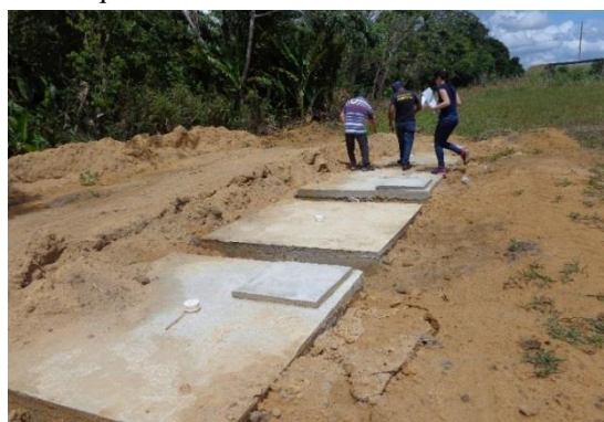
Figura 19: Sistema de fossa biodigestora no Eco Park São Joaquim
