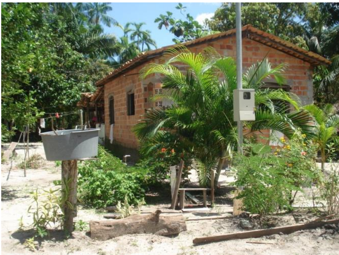
Figura 44. Registro de Energia Elétrica da Rede Celpa na comunidade São Francisco (foto do autor, 2011).
