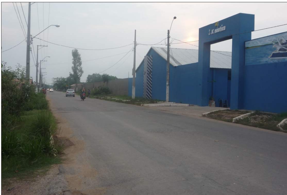
FOTO 26 – NÁUTICA NO BAIRRO SANTA RITA: uma das náuticas de maior porte da orla de Marabá. Esse tipo de empreendimento começou a se disseminar no bairro Santa Rita, principalmente, após a pavimentação da Avenida Transmangueira, na orla no rio Tocantins (Foto: Michel Lima, maio de 2012).
