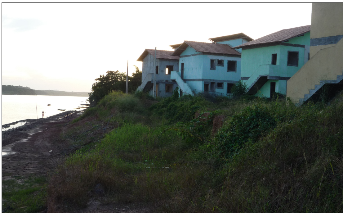
FOTO 28 – OBRAS DO PAC NO CABELO SECO: nesse espaço estão sendo realizadas as obras de infraestrutura de proteção das margens do rio Itacaiúnas, bem como estão sendo construídas as casas/apartamentos que serão entregues às famílias que moravam nesta parte da ribeira da cidade (Foto: Michel de Melo Lima, maio de 2012).
