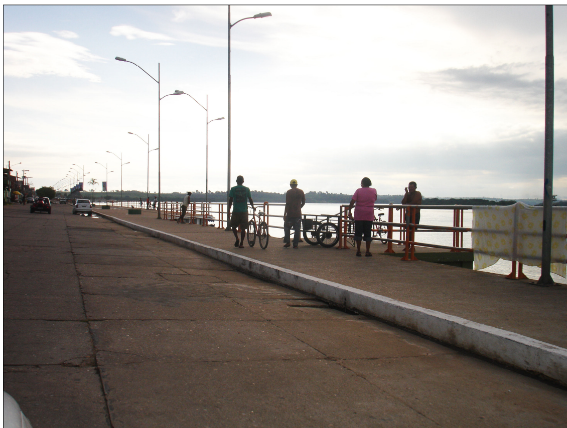
FOTO 01 – ORLA DA MARABÁ PIONEIRA: espaço onde foram realizadas as obras de infraestrutura (construção do calçadão e do cais de arrimo, melhorias na iluminação pública, pavimentação de vias etc.) e ponto mais movimentado da orla (rio Tocantins) (Foto: Saint-Clair Cordeiro da Trindade Júnior, janeiro de 2010).
