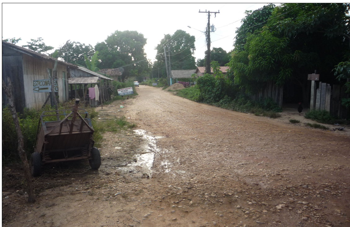
FOTO 18 – A COMUNIDADE DO GELADINHO: rua de piçarra que faz a ligação entre a comunidade do Geladinho, na beira do rio Tocantins, com o São Félix Pioneiro. Durante o período de cheia dos rios, parte da rua é tomada pelas águas, momento em que as pessoas só podem se deslocar da comunidade para outros locais de canoa e de outras pequenas embarcações. Geralmente esta rua é aterrada somente nos períodos de veraneio (Foto: Michel de Melo Lima, maio de 2012).
