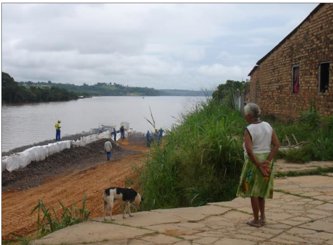
FOTO 12 – ORLA DE MARABÁ (BAIRRO FRANCISCO COELHO): senhora observando atentamente as obras de saneamento e construção do calçadão e do cais de arrimo às margens do rio Itacaiúnas, realizadas pelo governo (estadual e federal) através do Programa de Aceleração do Crescimento (PAC) (Foto: Michel de Melo Lima, abril de 2010).
